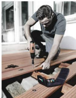
Битодержатель для завинчивания крепежа заподлицо на одинаковую глубину в террасную доску
