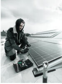
광전지 시스템 설치용 스크류드라이빙 공구 세트
