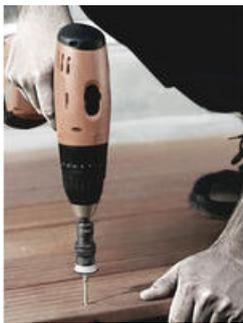
Portainseriti per l'annegamento a filo uniforme delle teste delle viti nelle tavole di legno nella costruzione terrazze
