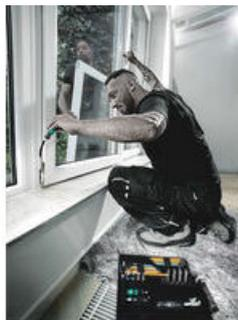
Con il giravite 393 S si può avvitare anche negli angoli. Grazie al gambo flessibile è possibile raggiungere viti di fissaggio posizionate sfavorevolmente. L'utensile ideale per situazioni di avvitamento difficili da raggiungere.
