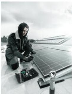
Jeu d'outils de vissage pour le montage d'installations photovoltaïques
