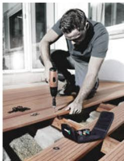
Porte-embouts pour noyer uniformément les vis dans les planches en bois pour la construction de terrasses
