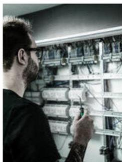
由于采用了曲线几何结构，因此可以操作普通螺丝刀无法触及的接线盒
